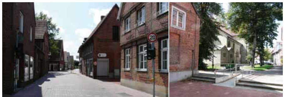
Der Shared Space Bereich in Legden und der barrierefrei gestaltete Zugang zur Kirche (planinvent 2011)
